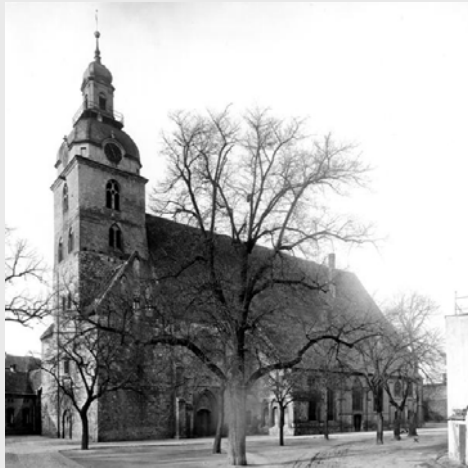
Brandenburg an der Havel, Stadtpfarrkirche St. Gotthard von Südwesten, Messbildaufnahme der Königlich Preußischen Messbildanstalt, 1895 (heute BLDAM)
