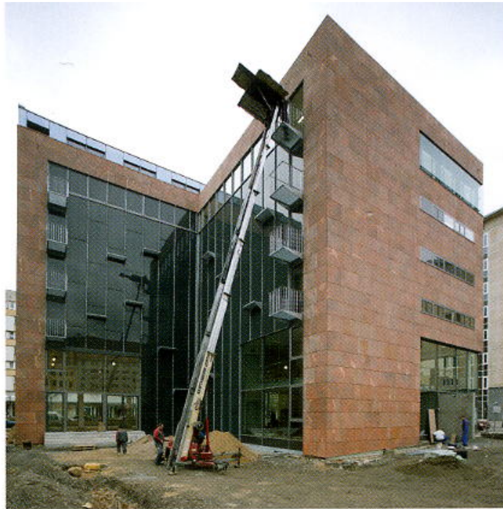
Ein Außenaufzug transportiert Groß- objekte in das künftige Schaumagazin im 4. Obergeschoss
